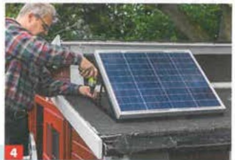
4 Gegen Windlast sollte man Solarmodule auf jeden Fall sichern – am besten mit einer soliden Schraubverbindung.
