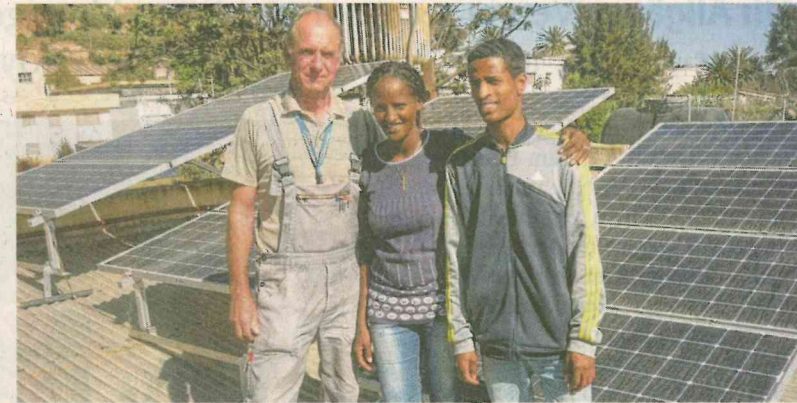
Eine Solaranlage zur Stromerzeugung hat die Memminger Phaesun GmbH auf dem Dach einer Klinik in Asmara, der Hauptstadt von Eritrea, installiert. Links Hans-Georg Knoop vom Verein Archemed, der das Krankenhaus unterstützt. Daneben die Mitarbeiter von Phaesun-Asmara Haimanot Okube und Temeshgen Tekle. Fotos: o
